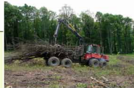
3. kép: Fűrésztelek felújítása
